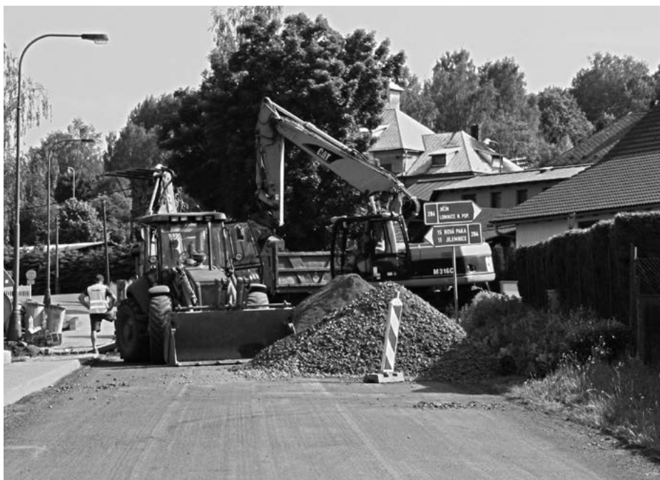
Výkopové práce na hlavní silnici.
