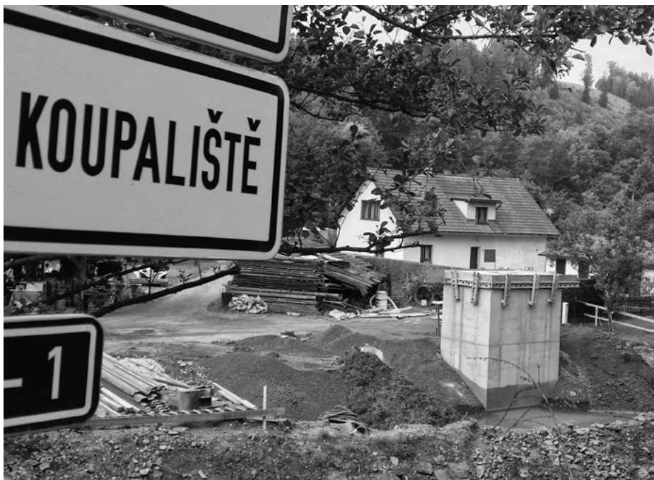
Betonový monolit pro čerpací stanici.
