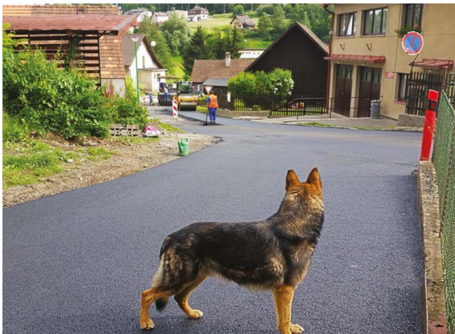
Pokládka u hasičské zbrojnice.
