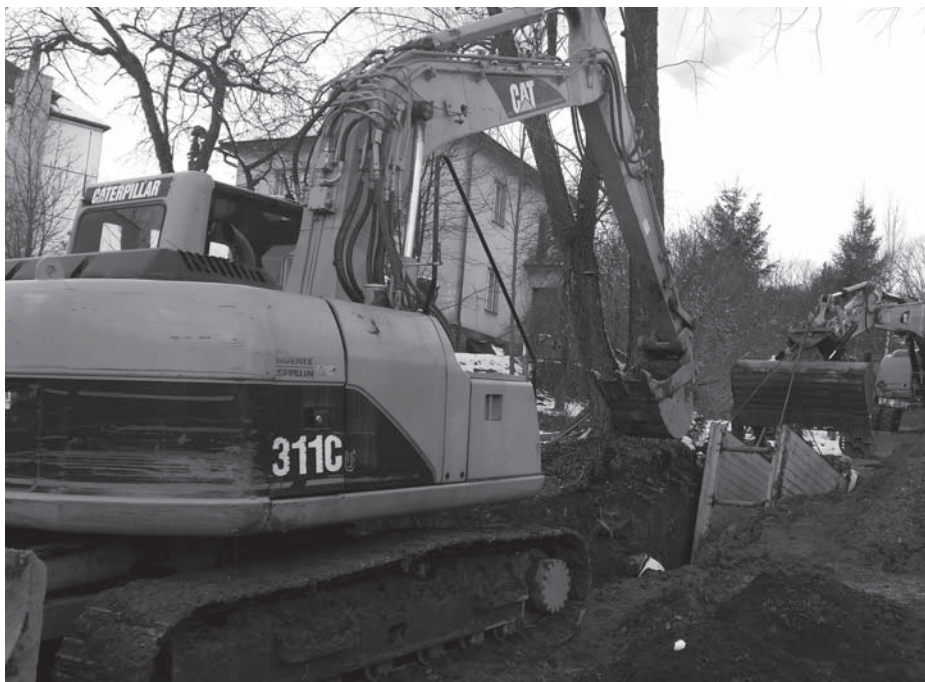
Stavba kanalizace směrem „na Výsluní.“
