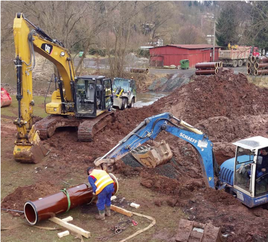
Z průběhu stavby kanalizace.
