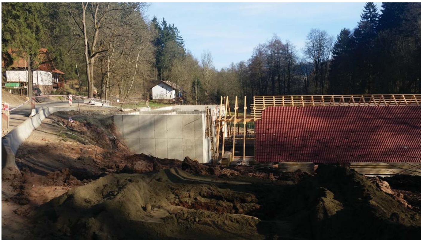
Stavba čistírny odpadních vod.
