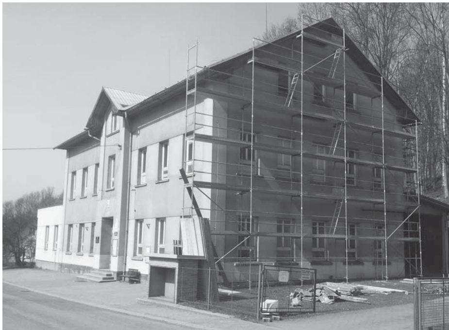
Stavební firma D-Bau ze Semil začala stavbou lešení zateplovací práce a výměnu oken (firma EGB navíc i výměnu kotle a ústředního topení) na Obecním domě v Kunderaticích.
