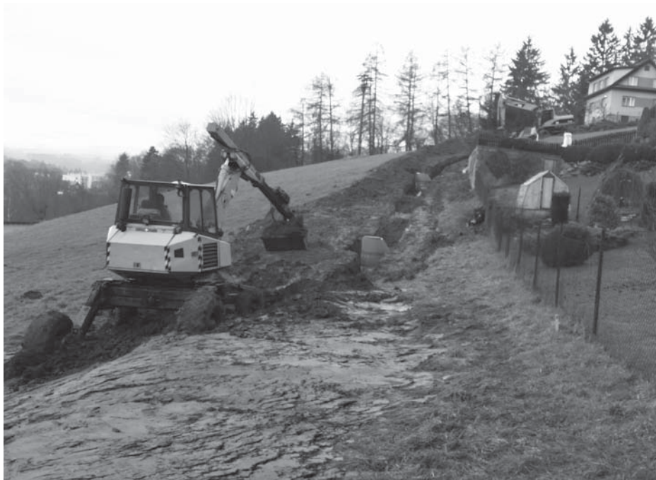
Stavba kanalizace na Letné.
