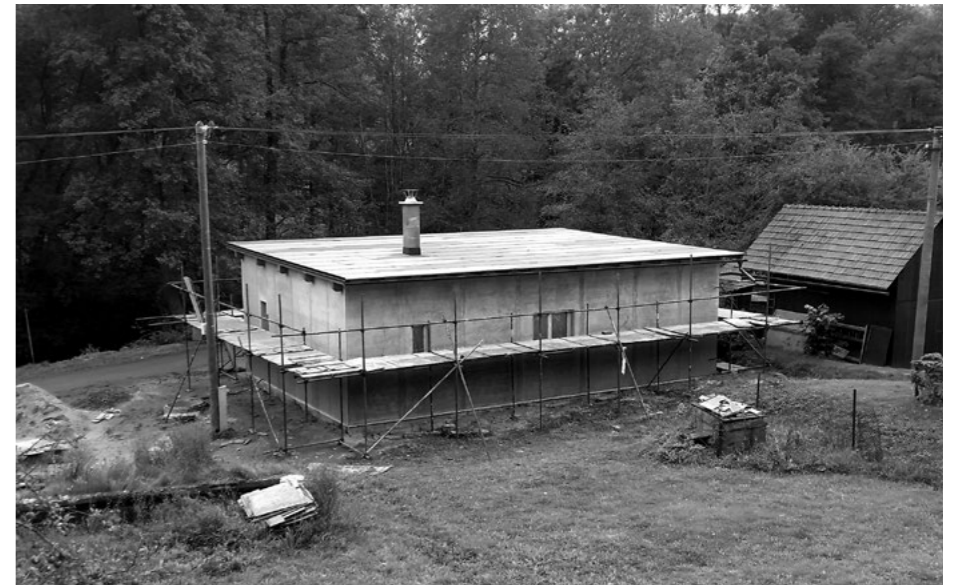
Budova rybníka je před dokončením, už jen fasáda, vnitřní vybavení a pak už jen oslavit úspěšnou stavbu a poděkovat všem, co se na tom podíleli.
