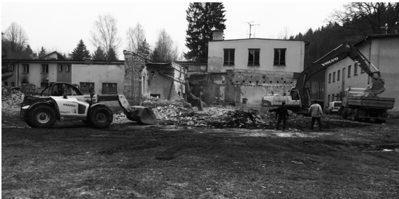
Demolice kotelny na Bareně
